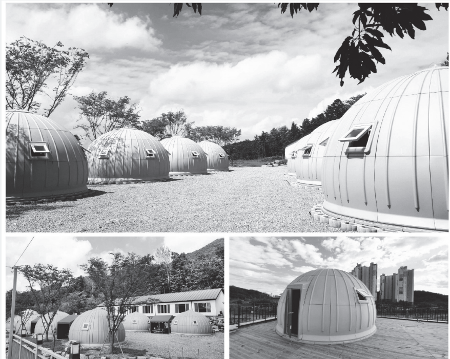
[그림 IV-1] 돔아일랜드 현장 설치 광경
